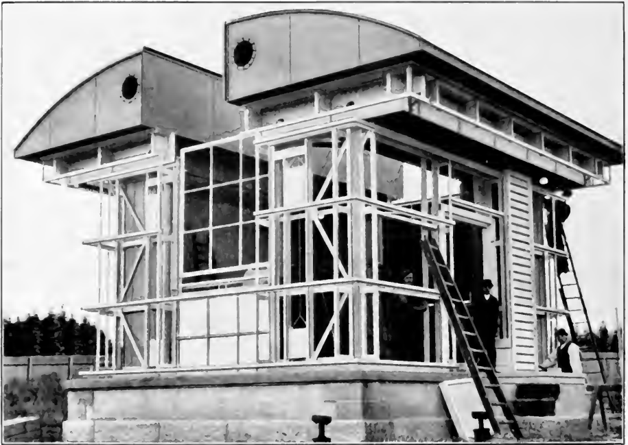
Gebäude für das Passageninstrument im Bau
